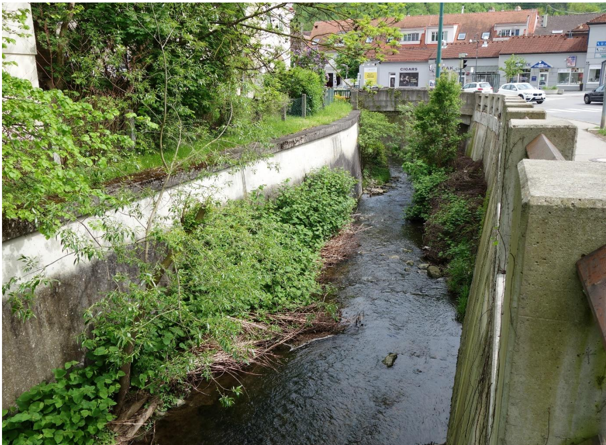
Abbildung 26: Der Gablitzbach ist im Ortsgebiet von Purkersdorf hart verbaut (Fotos: BPWW/J. Scheibelhofer)
